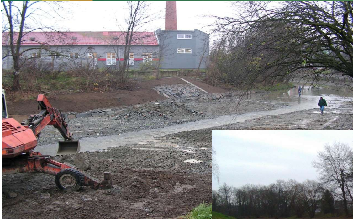
Odstranění nefunkčního jezu na Bystřici v Olomouci
